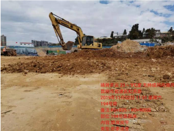
项目路面工程区
