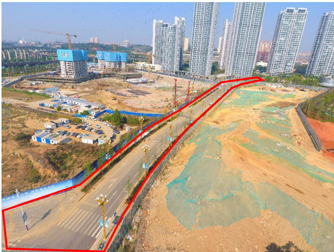
项目整体建设现状（二）
