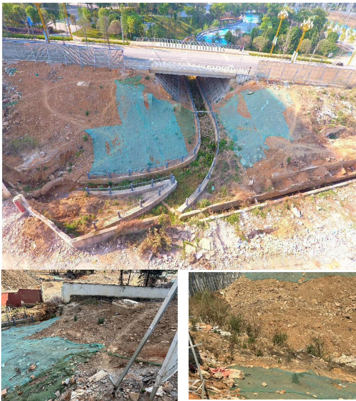
桥涵工程区现状
