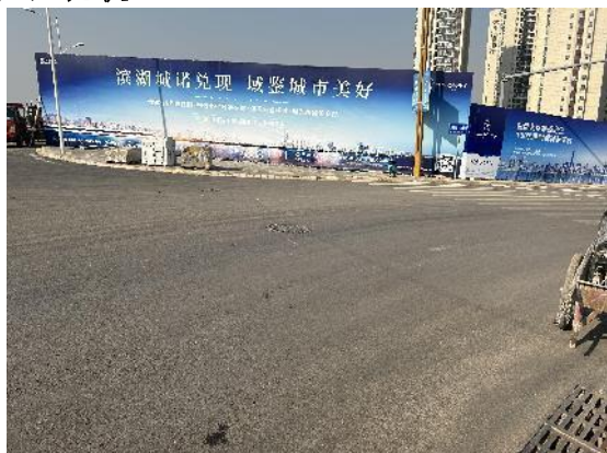
项目路面工程区 K0+000 段现状
