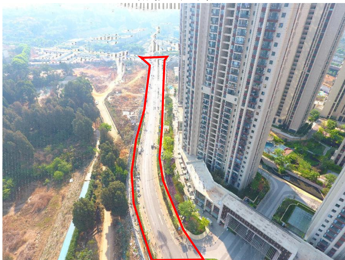
项目整体建设现状（一）
