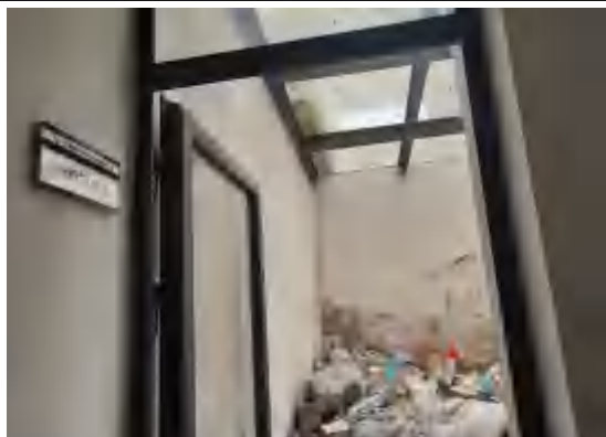
一般固废暂存间
