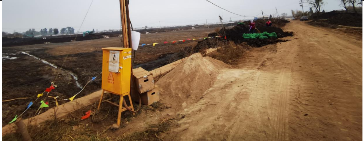
道路区建设过程情况（2022年12月-2023年4月）
