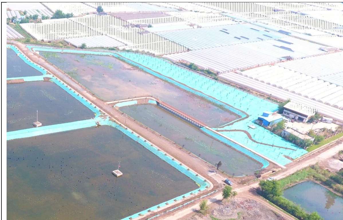
水生植物塘 8#建设过程情况（2022 年 12 月-2023 年 4 月）
