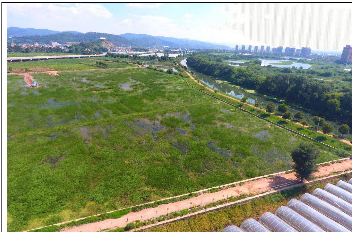
稳定塘区建成前情况 (2022 年 8 月)
