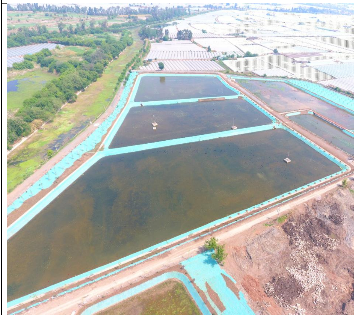
稳定塘区建设过程情况（2022 年 12 月-2023 年 4 月）
