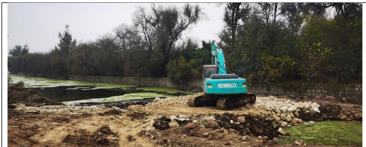
橡胶坝建设过程情况（2022 年 12 月）
