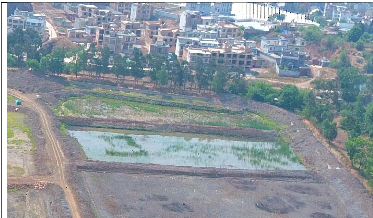
厌氧塘区建设过程中情况（2022 年 12 月-2023 年 4 月）
