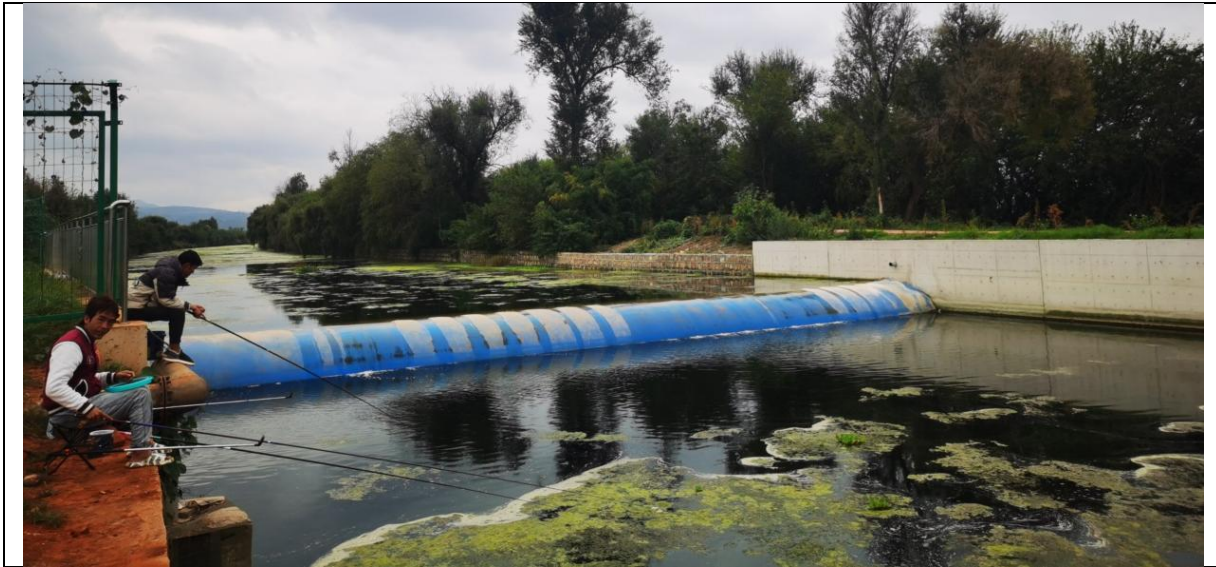
橡胶坝工程区现状（2023 年 9 月）
