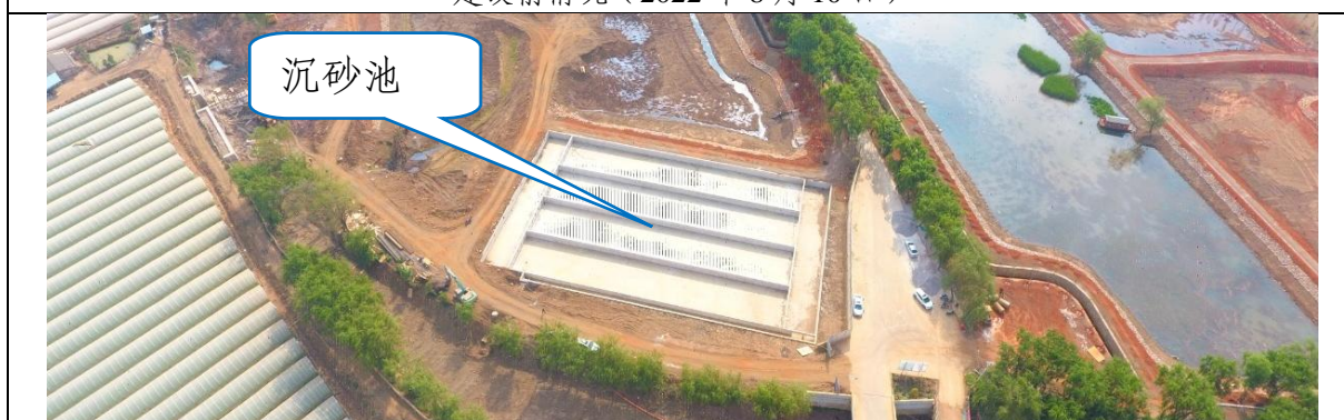
建设过程情况 (2022年12月24日)
