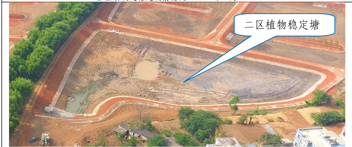
二区植物稳定塘施工期间情况（2023年4月26日）
