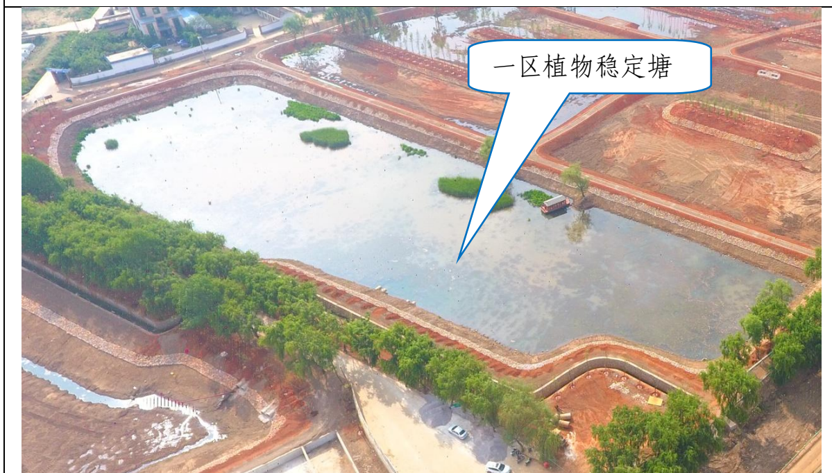
一区植物稳定塘施工期间情况（2023年4月26日）
