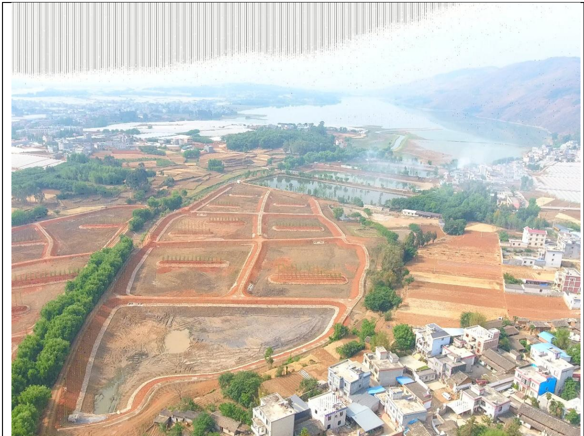
二区植物稳定塘、二区表流湿地、三区表流湿地一区表流湿地
