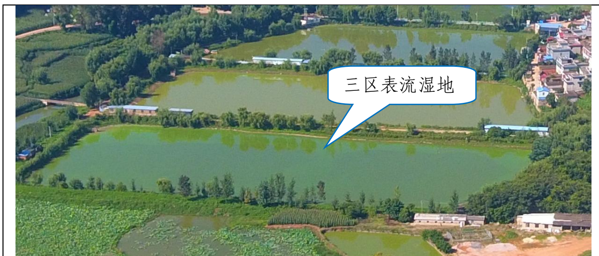
三区表流湿地施工前情况（2022年8月10日）
