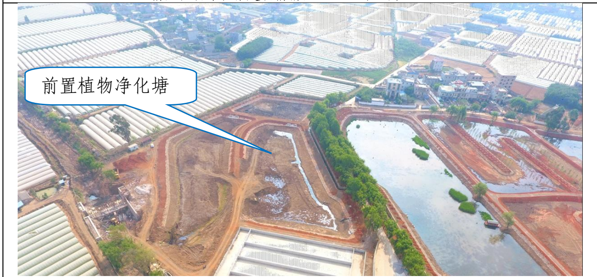
前置植物净化塘建设过程中情况（2023 年 4 月 26 日）
